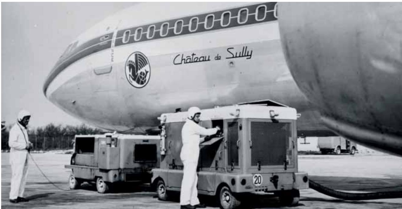
Mécaniciens en piste faisant des réglages sur un B707
